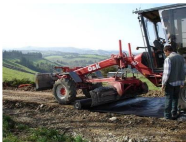
Pose du géotextile
