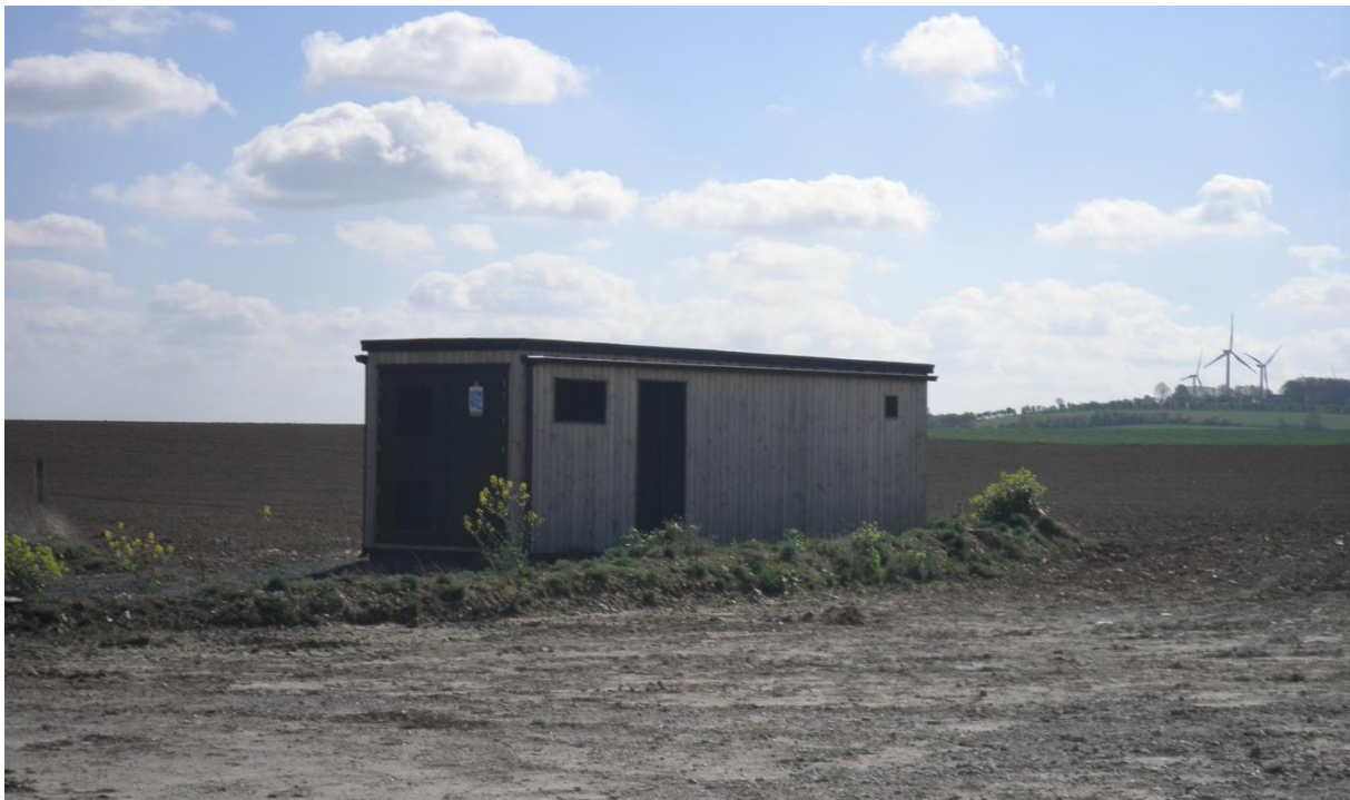
Poste de livraison qui sera mis en place
