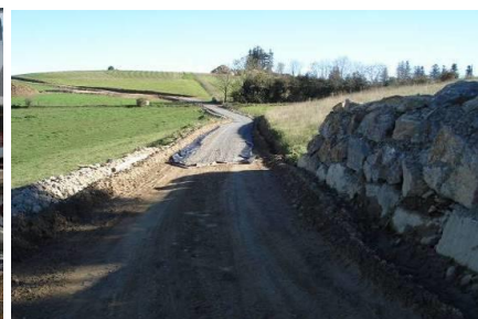
Mise en place du gravier
